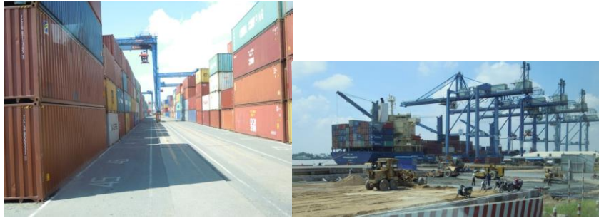
コンテナヤードとガントリークレーン
